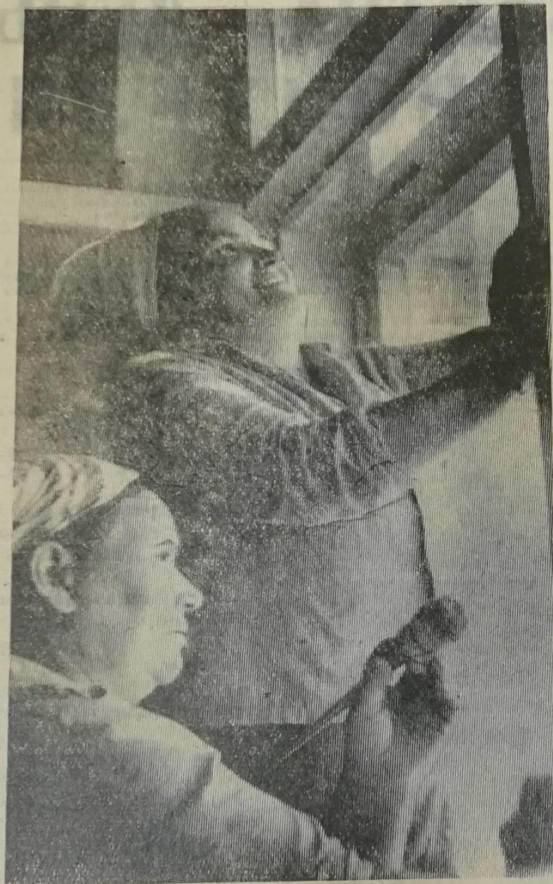
Бригада маляров УНР-101, которую возглавляет Т. Ф. Рыкова, — передовая на участке. Сейчас этот коллектив ведет отделочные работы на школе № 9, заказ решено выполнить раньше срока. НА СНИМКЕ: Т. Ф. Рыкова (слева) и Т. А. Скоробогатова.
